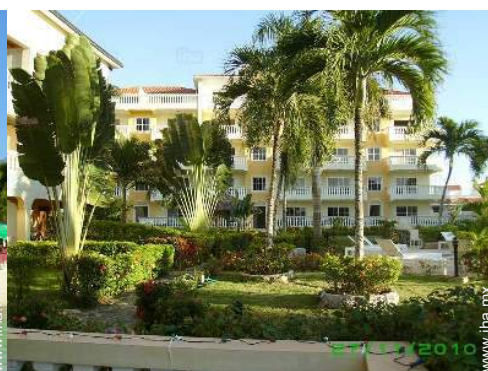
vista de conjunto
