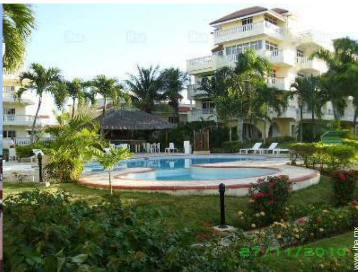
vista de conjunto
